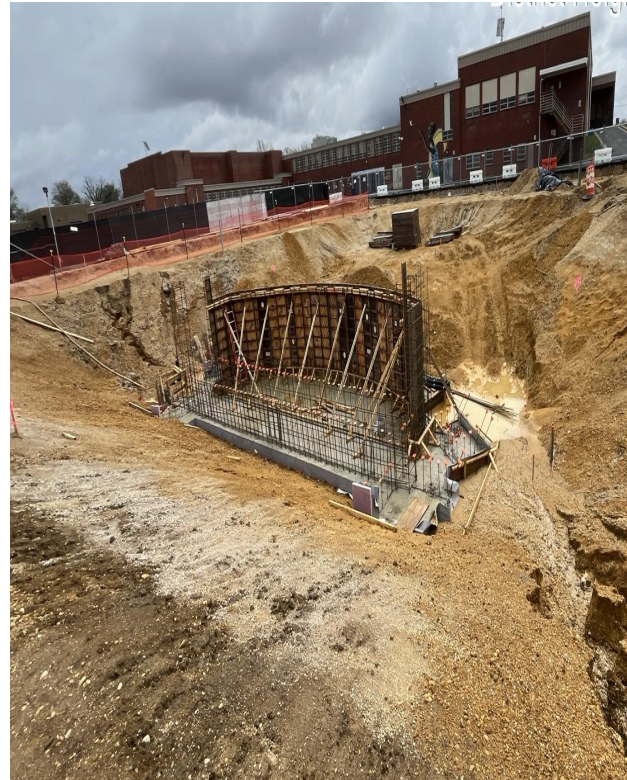
Fondation - Encadrement du mur de la fosse d'orchestre
