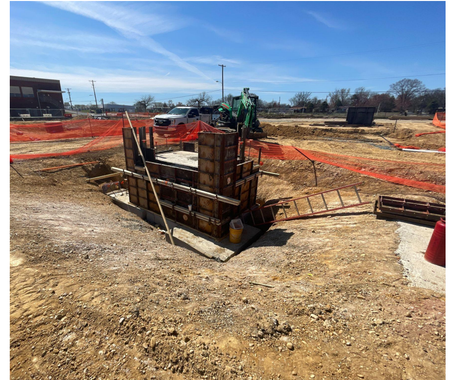
Fosse d'ascenseur et soubassement de l'escalier 2
