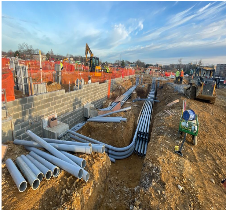
Installation d'une banque de conduits électriques
