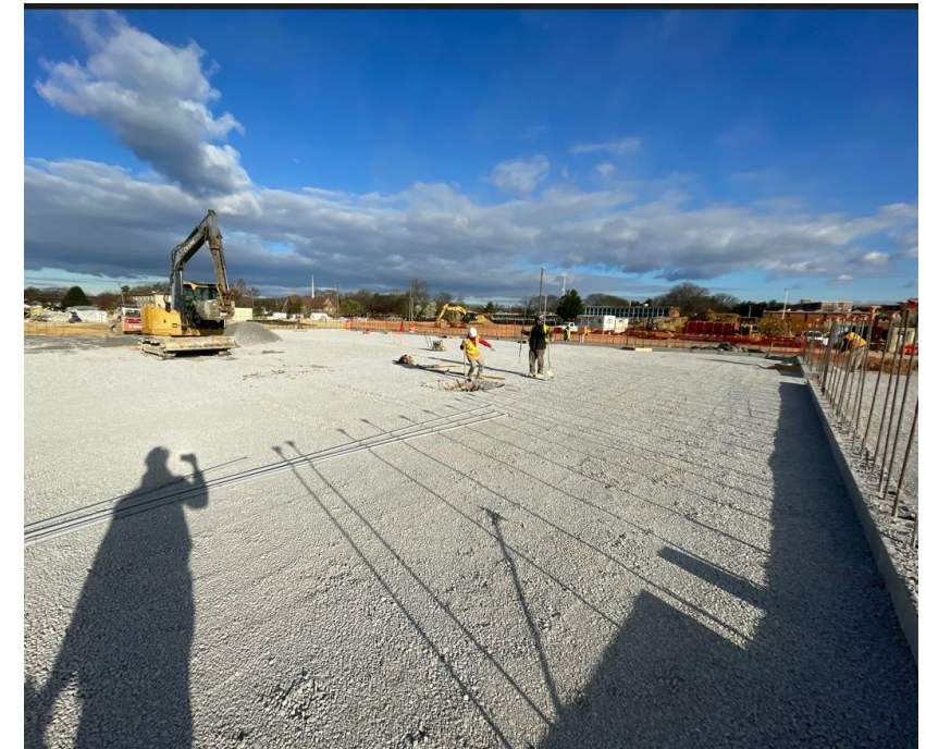
Préparation de la dalle de béton
