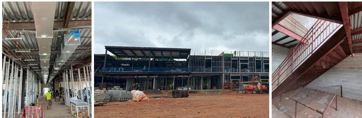
Les travaux de construction sur le site de l'école primaire Margaret Brent avancent régulièrement. Au cours du dernier trimestre, les travaux suivants ont été achevés : nivellation du terrain et de la plate-forme de construction, fondations du bâtiment, puits géothermiques, installation souterraine des équipements mécaniques, électriques et plomberie, et montage de la charpente métallique.
